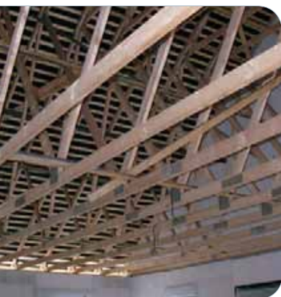
Charpente à fermette
