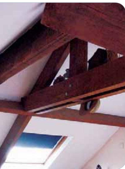
Éclairage des combles
